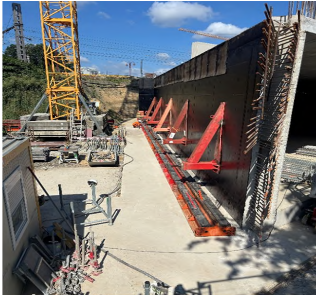
Préparation du ripage de l'ouvrage
