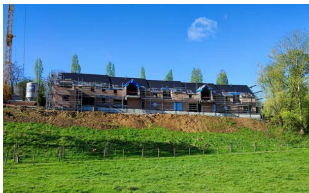
Chantiers Notre Maison, scavée du Biéreau et rue Michel de Ghelderode.
