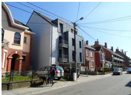
Construction sur une « dent creuse » d'un immeuble de 6 appartements à front de rue.
